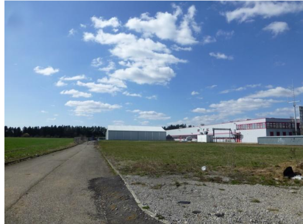
Blick nach Westen mit Werk (rechts), temporär geduldeter Halle (Mitte)
