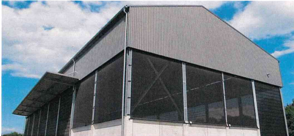
linkes Bild: Müllumladestation des Landkreises Fulda
