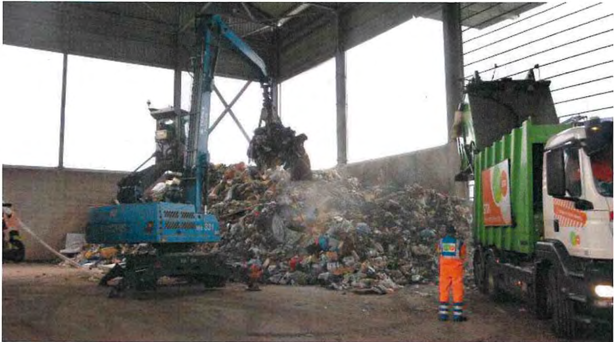
Müllumladehalle mit Stahlbetonwänden und aufgesetzter Stahlhalle (Landkreis Fulda)
