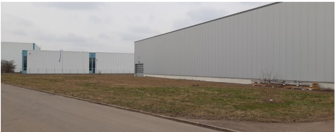
Abb. 6: Blick auf das Untersuchungsgebiet aus südlicher Richtung mit der Grünfläche im Vordergrund und der Lagerhalle im Hintergrund.
